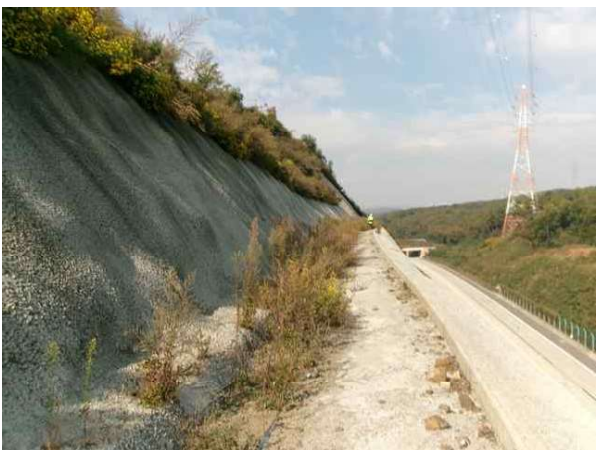
1소단 배수로 전경
