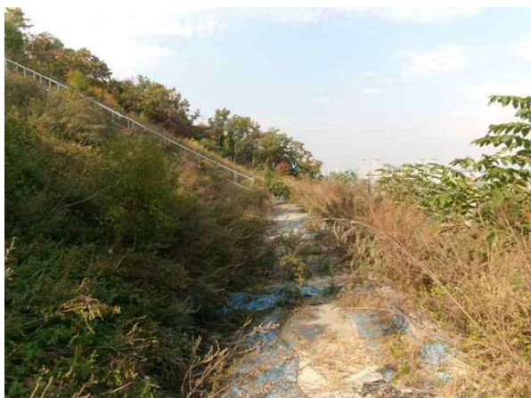
1소단 배수로 전경
