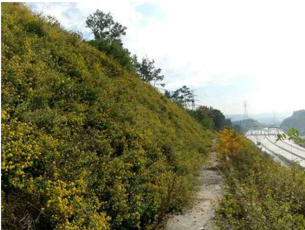
1소단 배수로 전경
